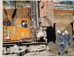
地盤改良工事に
