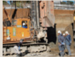
地盤改良工事に
