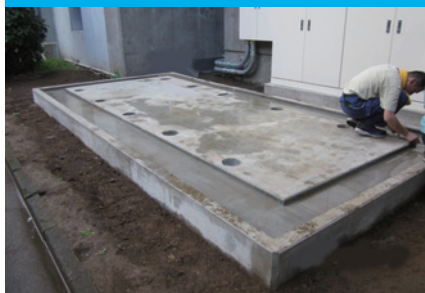
発電機を固定する基礎を設置します。
