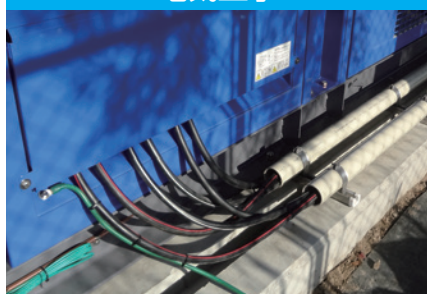
発電機と、設置する施設の電源との配線工事を行います。
