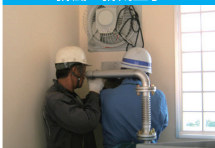
屋内に設置する場合、排気・排風を外部へ逃がす様に、排気管の延長をおこないます。
