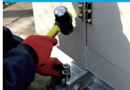
アンカーボルトを打ち込み、発電機を基礎に固定します。
