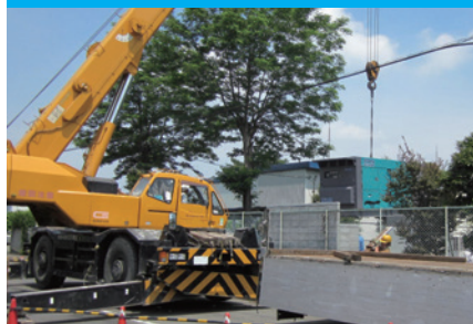
ラフタークレーンなどで、発電機を設置する場所まで移動させます。
