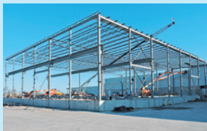
建設中の板金工場棟
