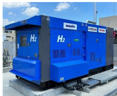
水素混焼発電機
