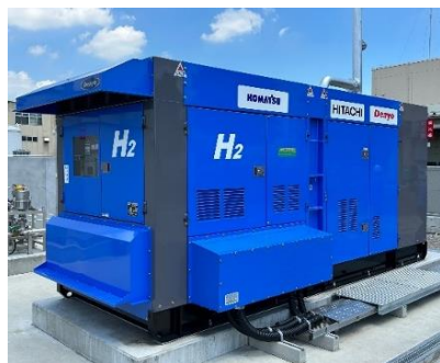
水素混焼発電機
