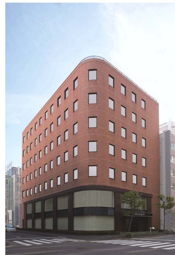
本社（日本橋堀留町）
