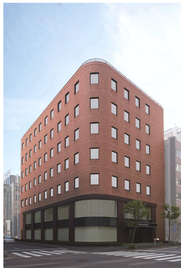
本社(日本橋堀留町)
