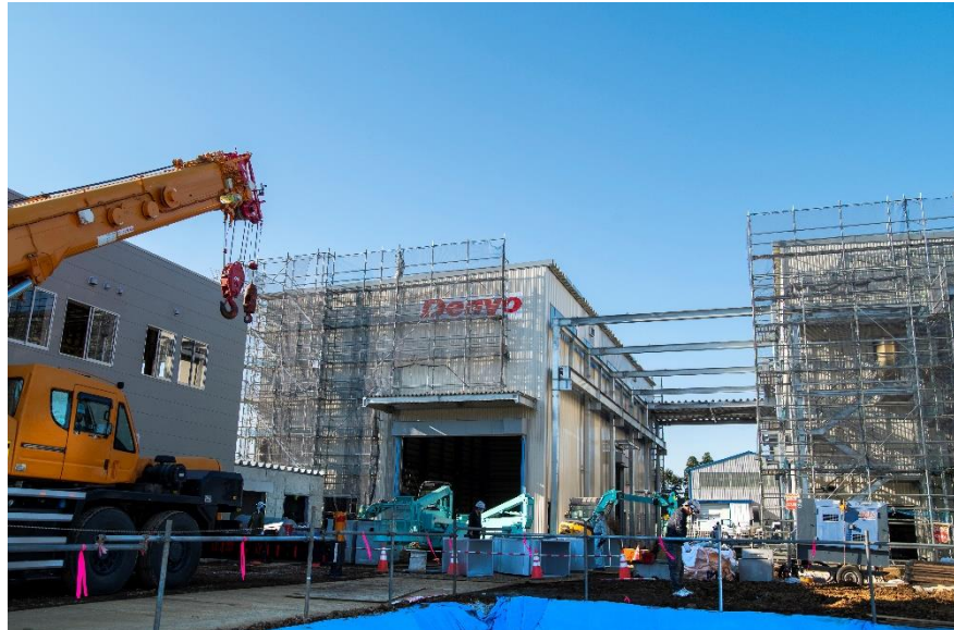
建設中の大型修理拠点(千葉県佐倉市)
