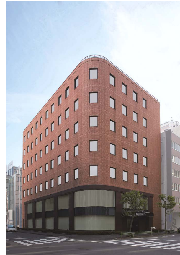
本社（日本橋堀留町）
