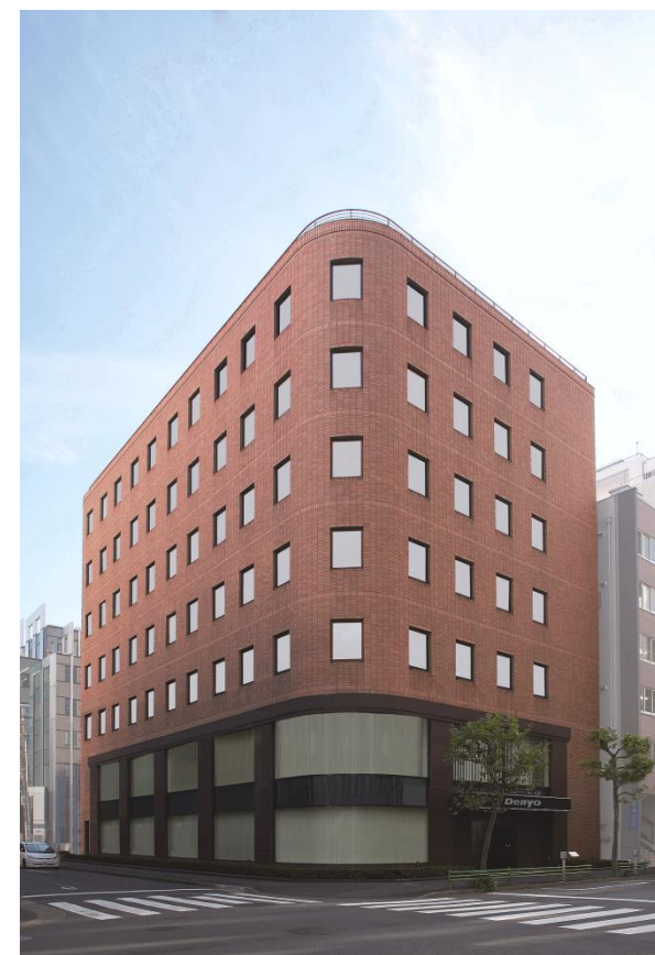
本社（日本橋堀留町）
