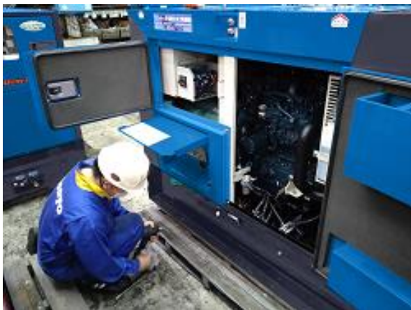
発電機納入時の機械内部点検
