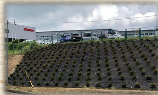
第2期植栽工事(福井工場)
