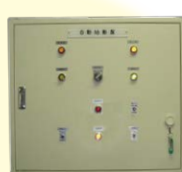
自発停型発電機※1 電源切替盤(ATS盤)※2
