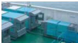
800kVA 発電機と220kVA 発電機との並列運転イメージ
