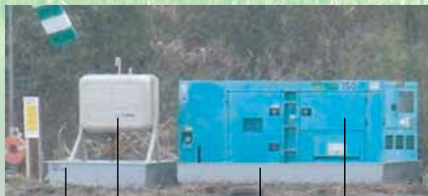
外部燃料タンク 燃料タンク用防油堤 発電機本体 発電機用防油堤
