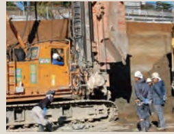
地盤改良工事に
