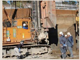
地盤改良工事に
