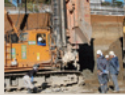
地盤改良工事に
