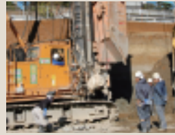
地盤改良工事に
