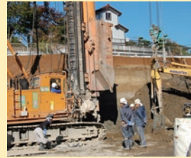
地盤改良工事に
